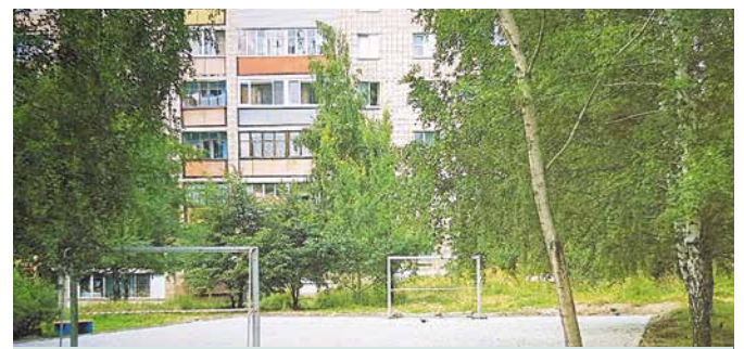
Заасфальтирован участок дороги и тротуара между домами № 116 и № 108 по ул. Выборной
